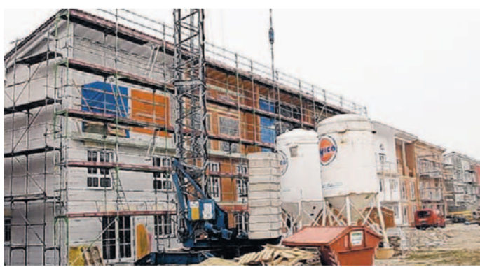
Die umstrittene Baustelle in Garching-Hochbrück. FOTO: FÖRTSCH
