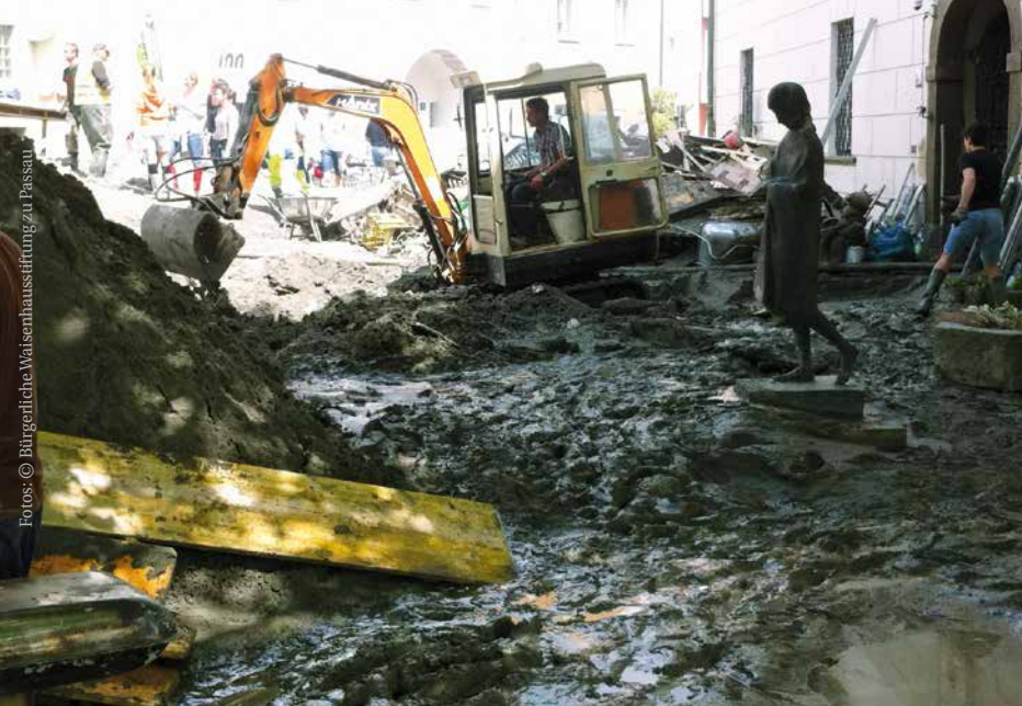
Nach dem Wasser kamen die Aufräumarbeiten – tagelang haben die Helfer geschippt
